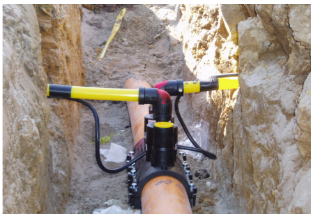
MAGNETIC VALVE horizontal verlegt für max. Deckung
