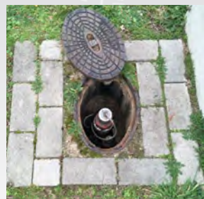
Einbau via Unterflurhydrant
