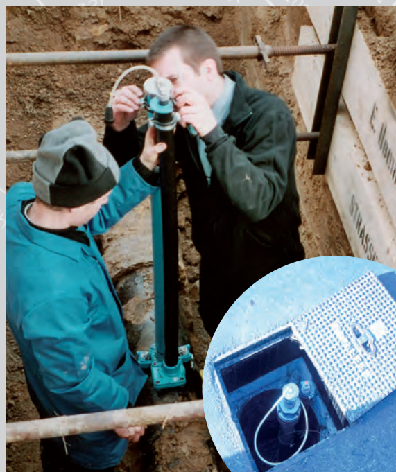
Einbau via Martinek Messschleuse
