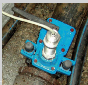
Einbau via Anbohrschelle
